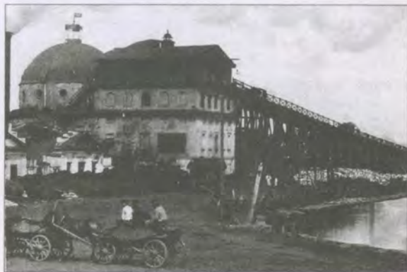
Домна Шайтанского завода XIX в.
