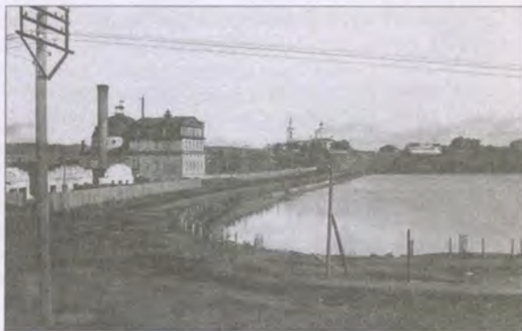
Плотина и домна Шайтанского завода XIX в.
